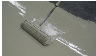
mit Stachelwalze überarbeiten
