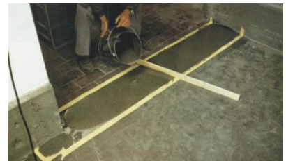
Reparaturen, Löcher ausfüllen
